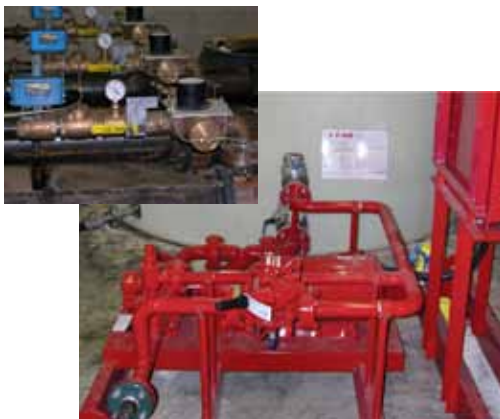
Sistema de Bomba de Presión Balanceada
